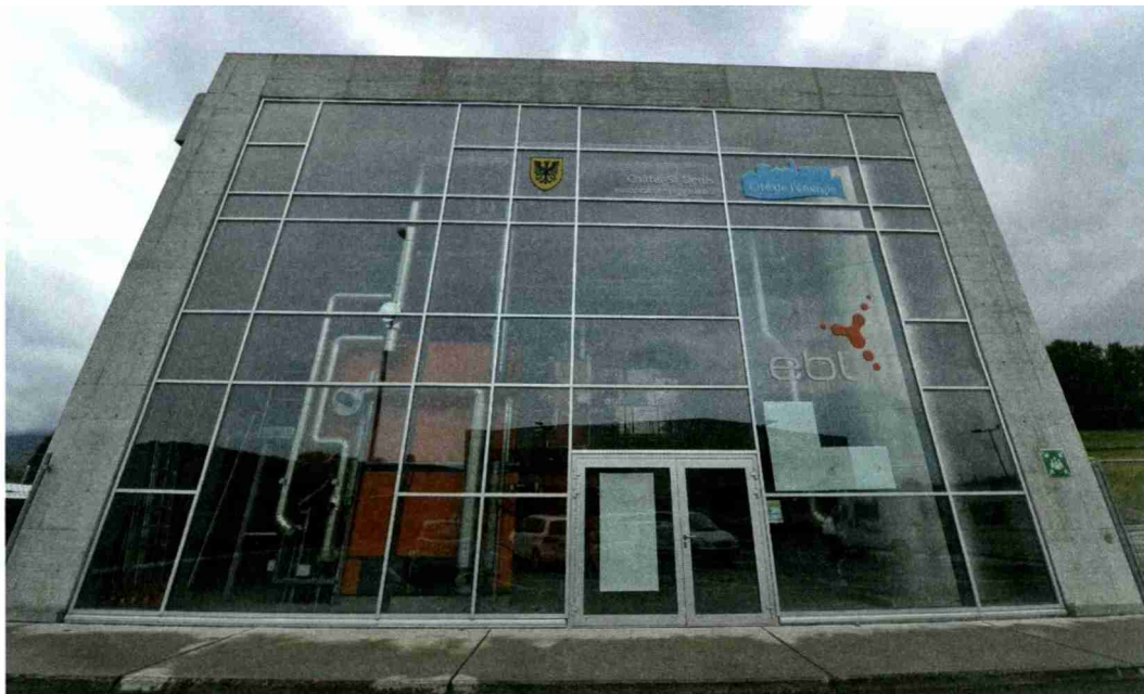
Das Beton- und Glasgebäude lässt den Blick auf die Stahlrohre und die orangen Heizkessel frei.
