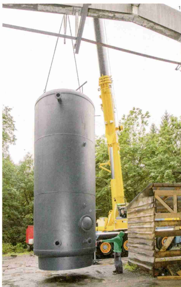
1 Anlieferung des Warmwasserspeichers
