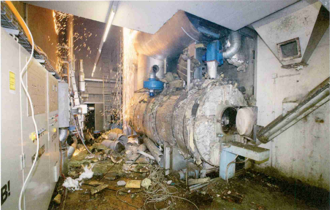
2 Abbruch der alten Heizzentrale
