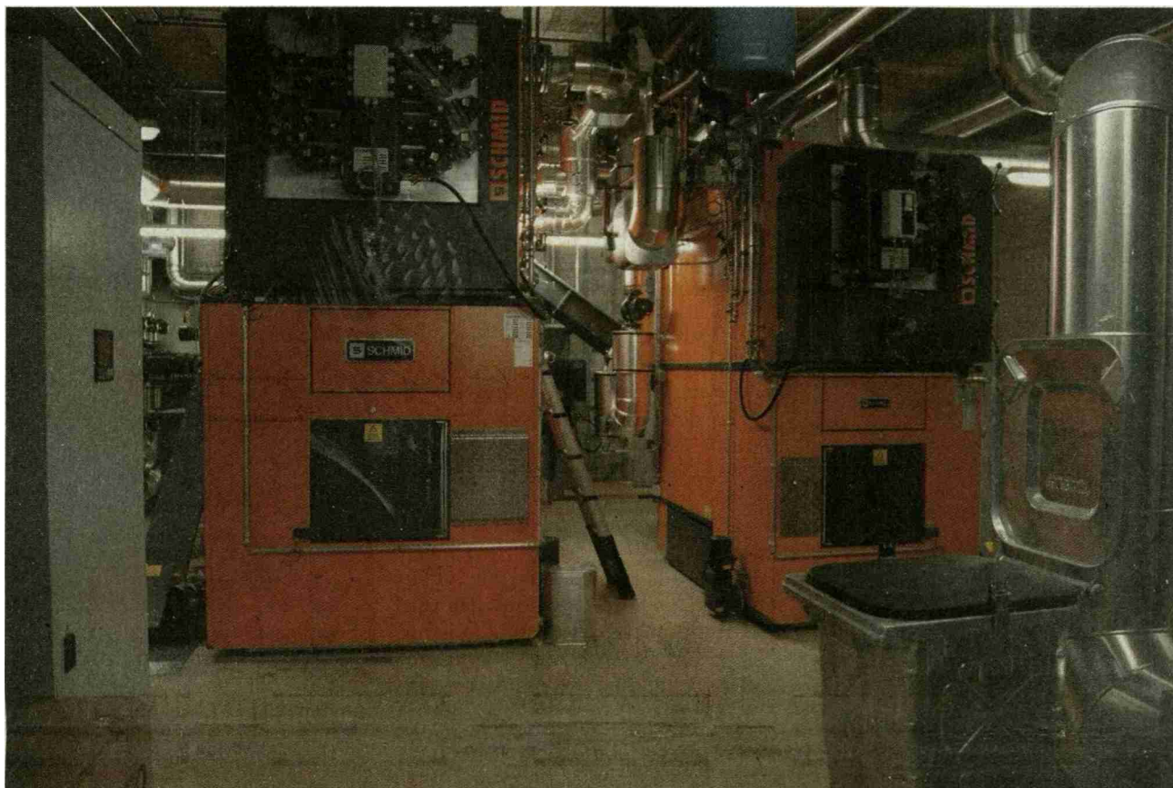
Die Heizzentrale in Riggisberg produziert seit einigen Monaten Wärme aus Holzschnittel für 40 Kundinnen und Kunden.
